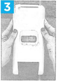
Presser le distributeur contre le mur en s'assurant que les côtés soient à la verticale et bien alignés avec les tuiles.
