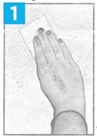
Utiliser le tampon d'alcool inclus dans l'emballage pour nettoyer la surface du mur. Laisser sécher complètement.
